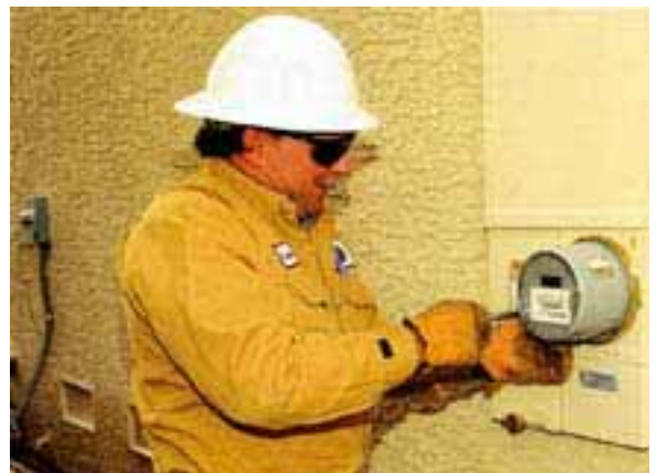
Электромеханик Ланс Агирре из компании Nevada Power, устанавливающий счетчик
